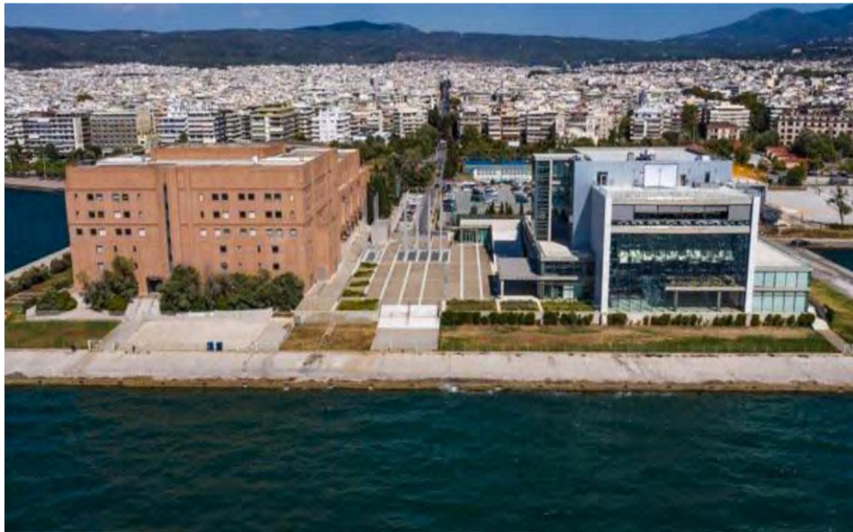
Εικόνα 2: Κτίρια M1 & M2 από την νότια πλευρά
