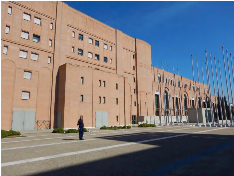
Εικόνα 3: Κτίριο M1 από την ανατολική πλευρά
