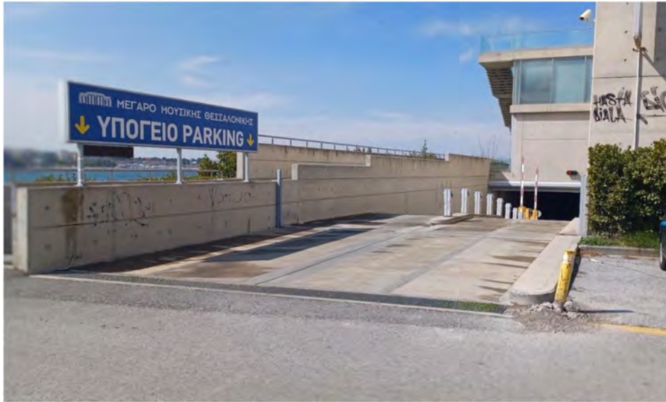
Εικόνα 6: Υπόγειος χώρος στάθμευσης κτιρίου M2
